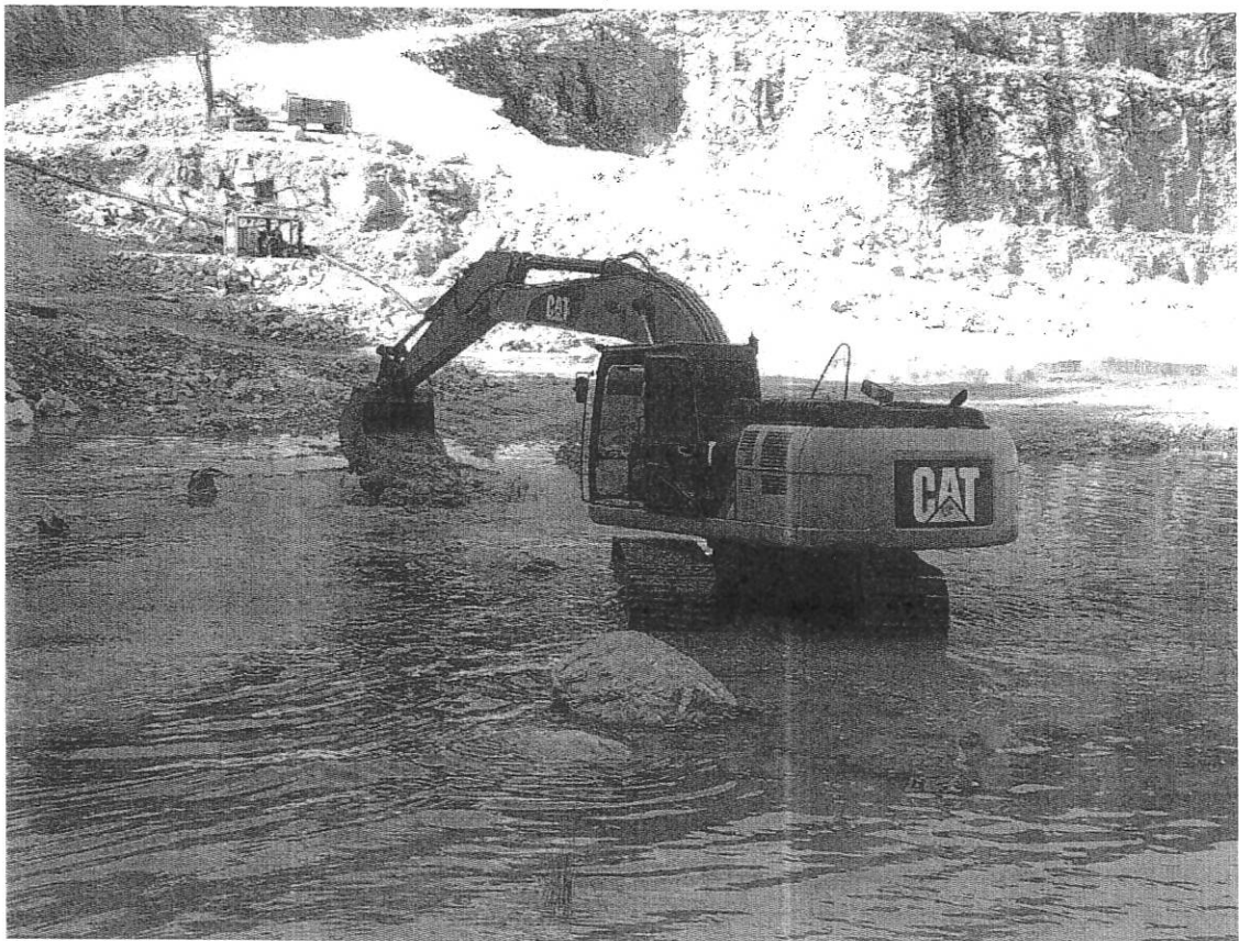
ภาพที่ 1.2 การขุดลอกบ่อตกตะกอน
